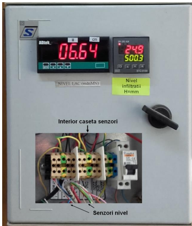
Fig. 6 – Panou afisaj nivel apa baraj
